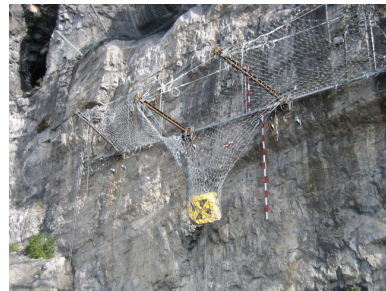
Rys. 2. Przykład wykorzystania koszy gabionów do budowy ścian oporowych (a), oraz kurtyn skalnych (b) [3]
