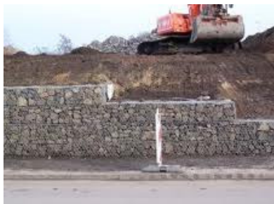
Rys. 2. Przykład wykorzystania koszy gabionów do budowy ścian oporowych (a), oraz kurtyn skalnych (b) [3]
